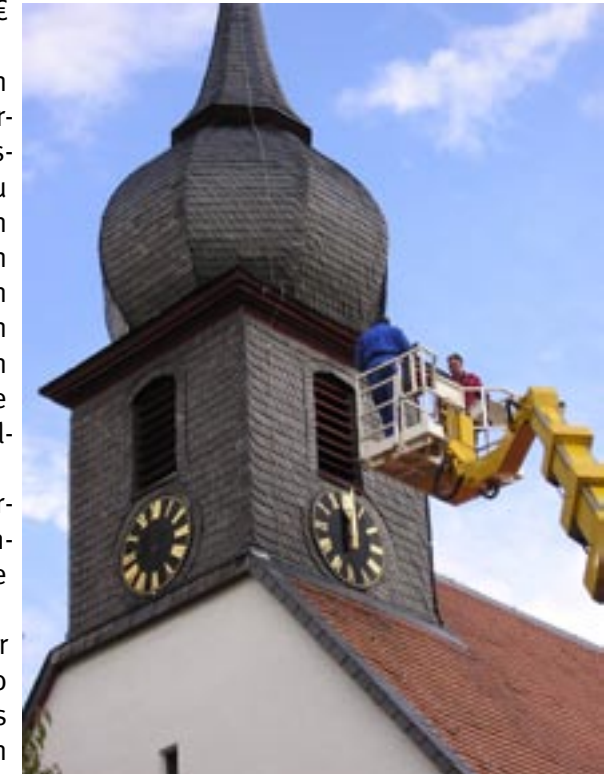
Alte und neue Zifferblätter mit und ohne Zeiger bei der Montage. Foto: AWR
